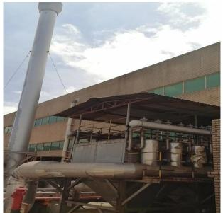
熔铸废气排气筒
